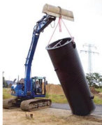
Fertigteilschächte aus PE-HD sind so leicht, dass sie mit einem Bagger angehoben werden können.
